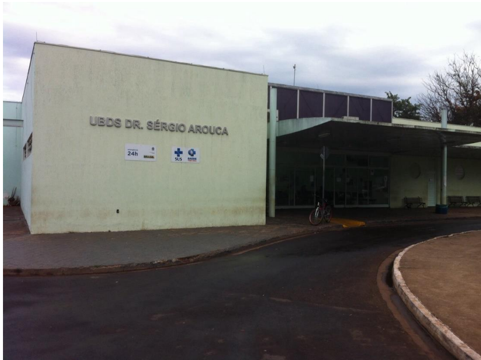
Figura 5. Foto da fachada da UBDS Quintino II.
