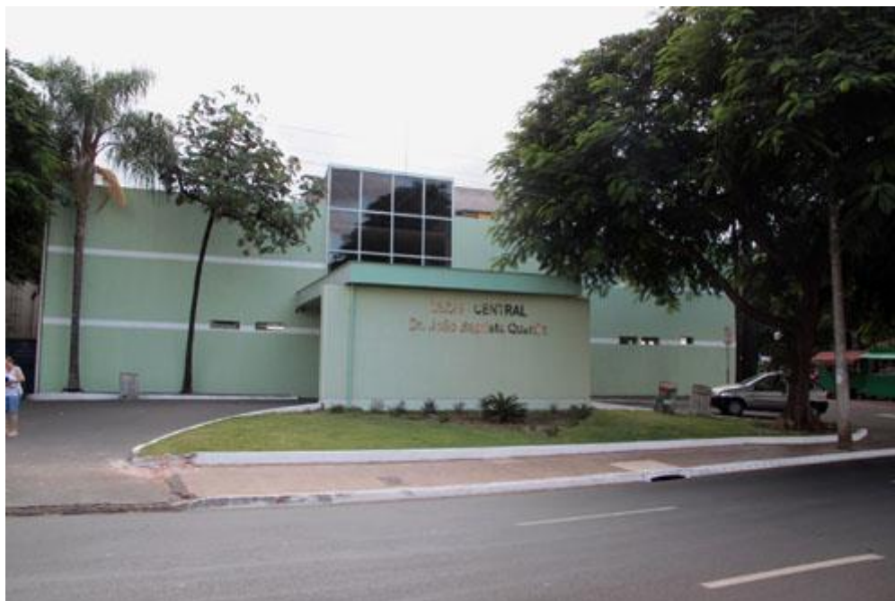
Figura 4. Foto da fachada da UBDS Central.
